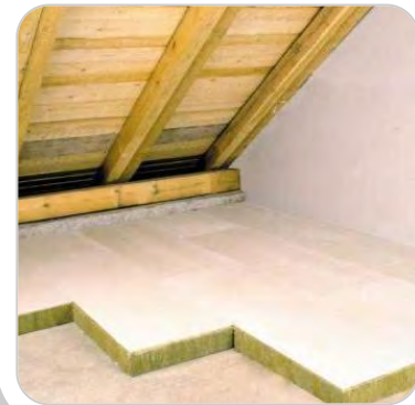
Dämmung mit begehbaren Dämmplatte
