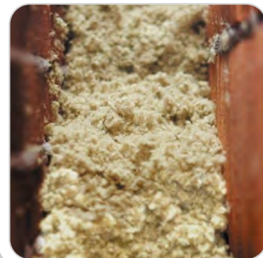
Dämmstoff zwischen den Mauerschalen
