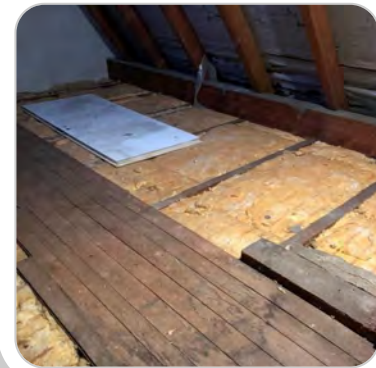
Dämmung einer obersten Geschossdecke mit ökologischem Dämmstoff
