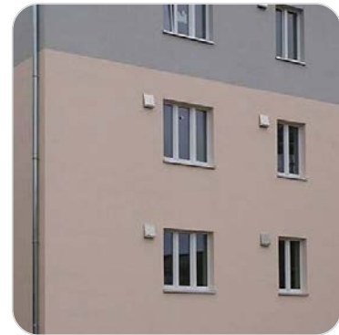
dezentrale Lüftungsanlage
