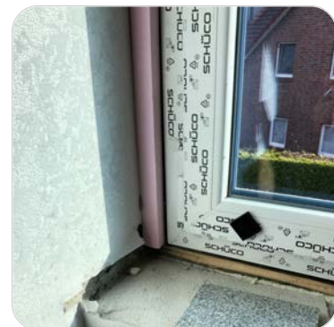
Dämmung der Fensterlaibung
