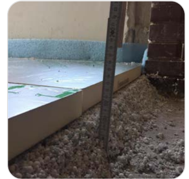
Dämmung der Sohle
