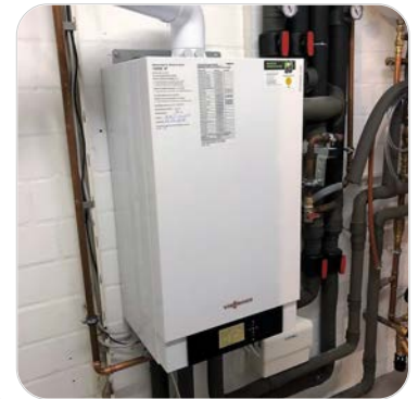
Gas-Brennwertheizung
